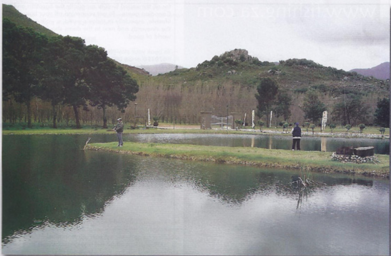
Dam number 3 on La Ferme.
